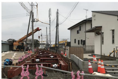
構造物際での施工
