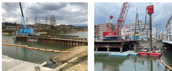
ため池・河川堤防での施工
