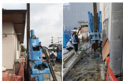
民家際での近接施工
